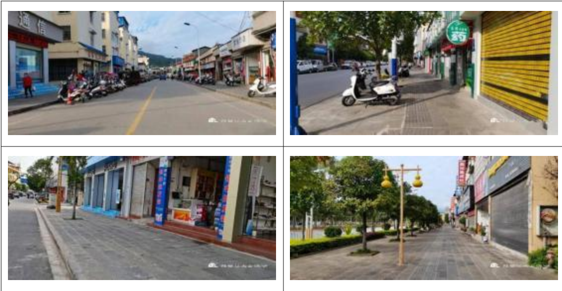
图 4.1-4 沿街商铺现状照片
