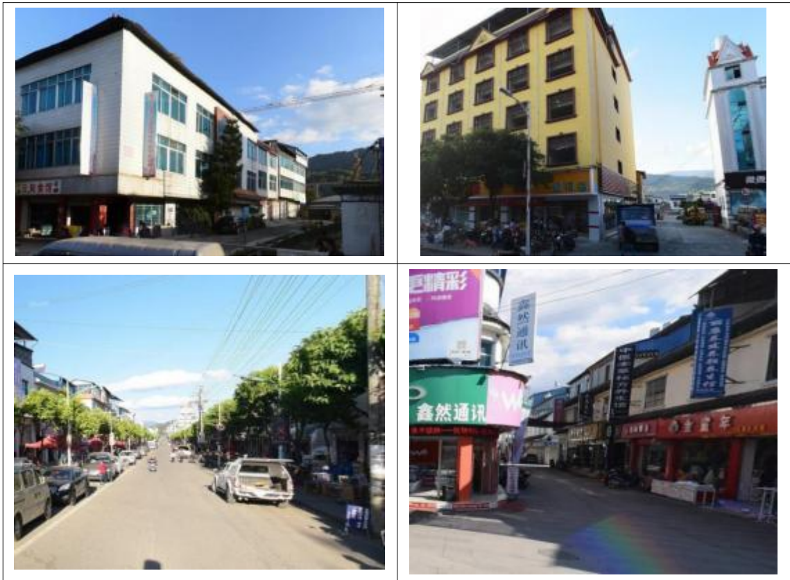
图 4.2-1 现状老城区道路
