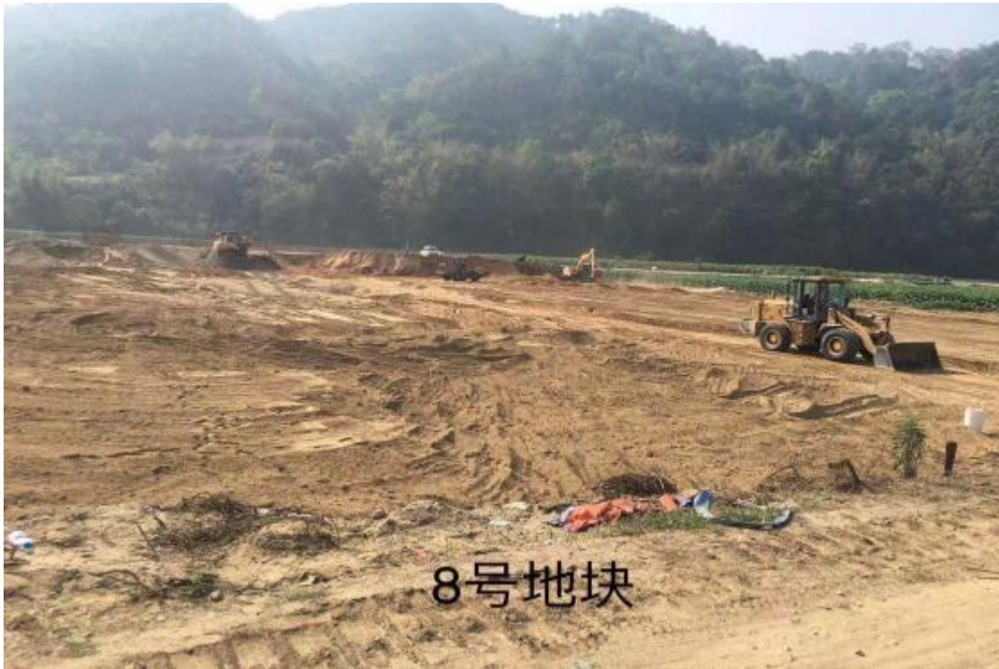
8 号地块整改前照片
