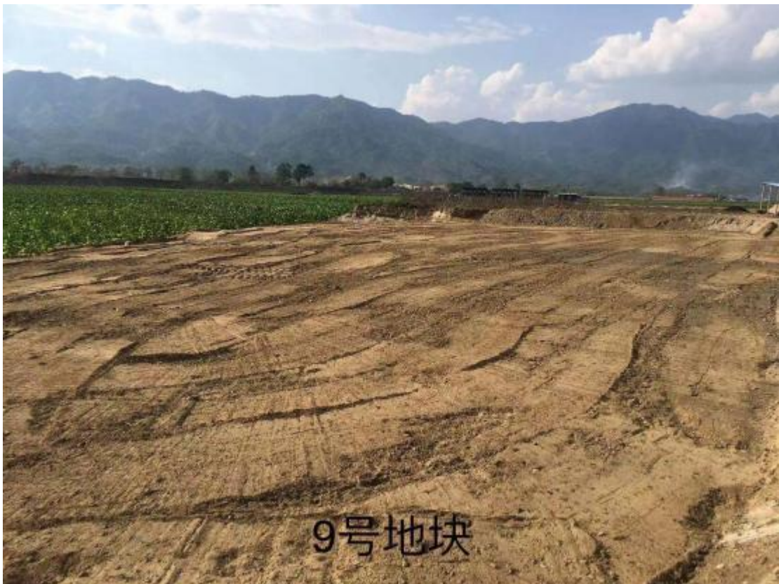
9 号地块整改后照片
