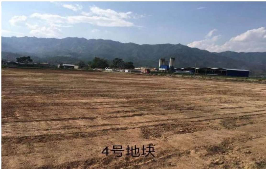
4 号地块整改后照片
