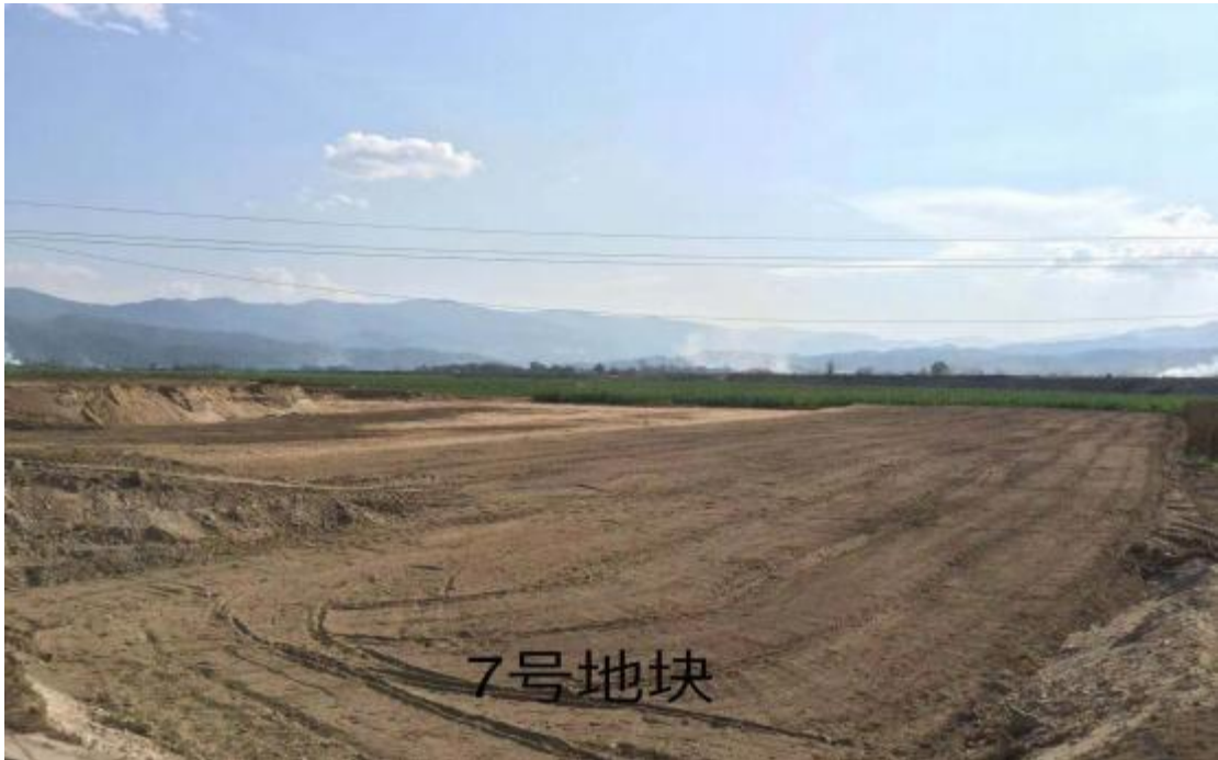
7 号地块整改后照片
