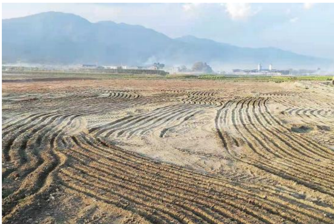
1 号地块整改后照片
