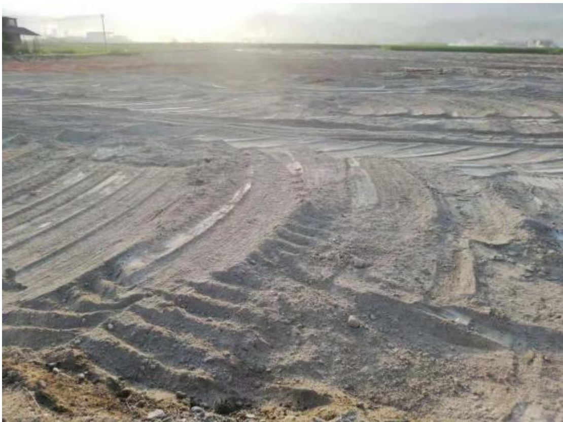
3 号地块整改后照片
