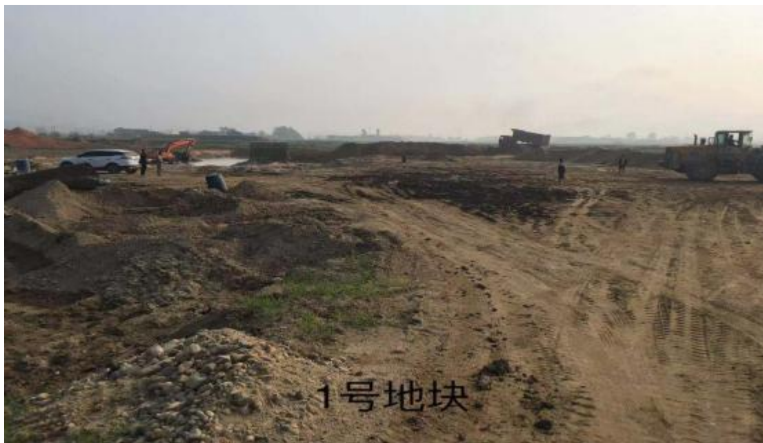
1 号地块整改前照片
