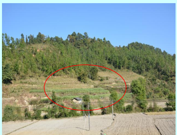
大坝生产生活区
