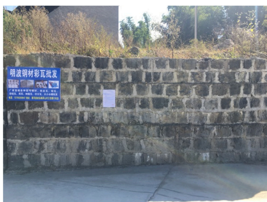
居民出入口公示
