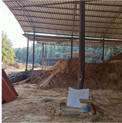
原料堆场现状
