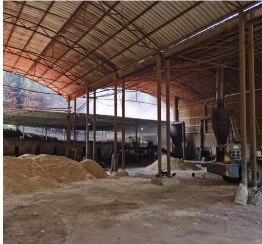
生产车间现状
