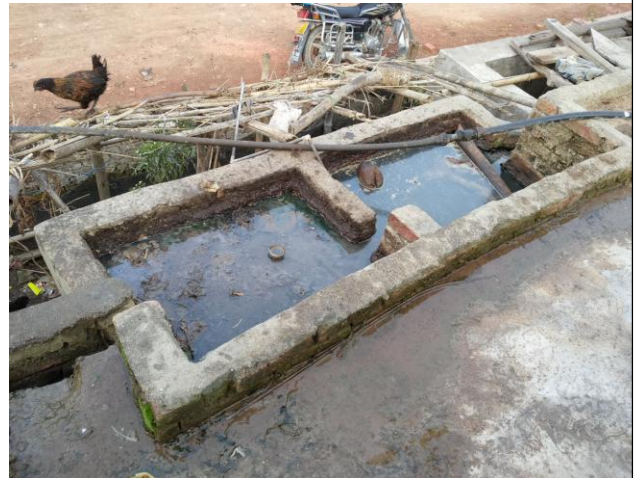
生活污水沉淀池
