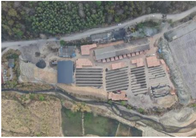
项目厂区工程现状
