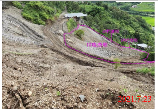
现有 1#排土场 (即废渣场)
