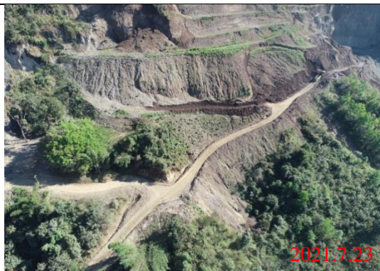
运输道路现状
