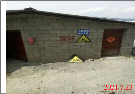
现有柴油储存间
