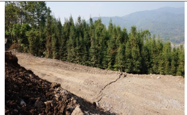
进场道路现状
