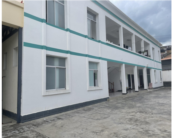
卫生院东侧公共卫生服务中心现状
