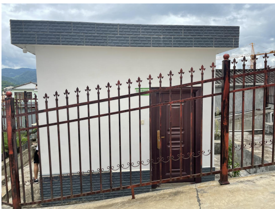
污水处理系统室现状
