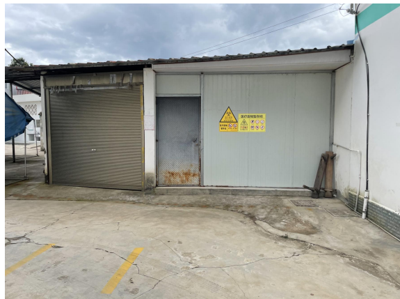
项目医疗废物暂存间、柴油发电机房现状
