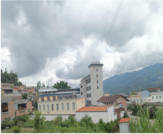
卫生院东侧公共卫生服务中心现状
