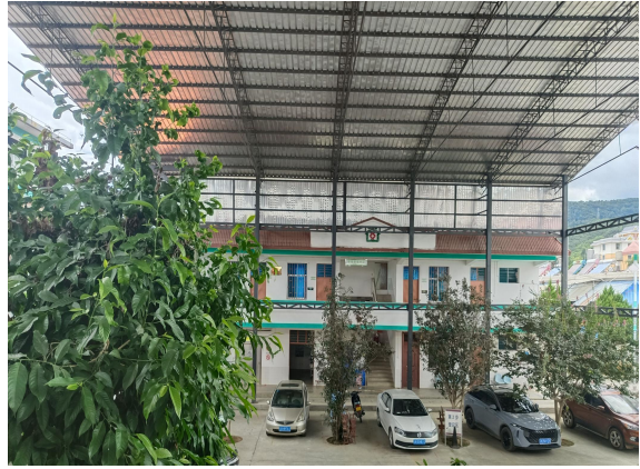
慢性病综合楼现状
