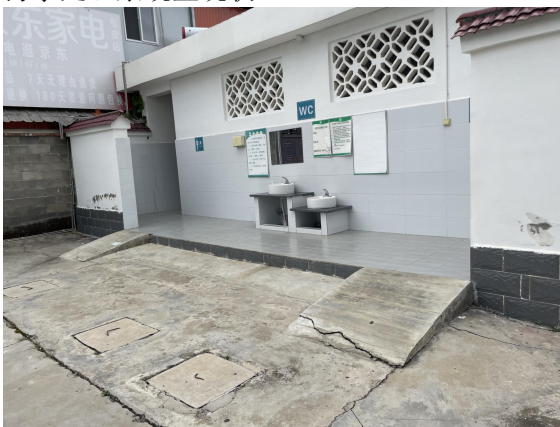
东北侧公共卫生间现状
