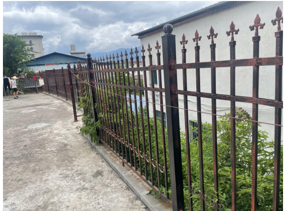
项目区西南侧现状
