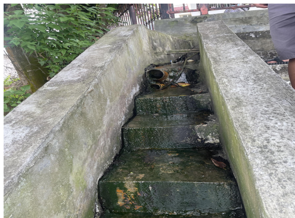
项目区总排污口现状
