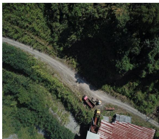
矿区道路现状
