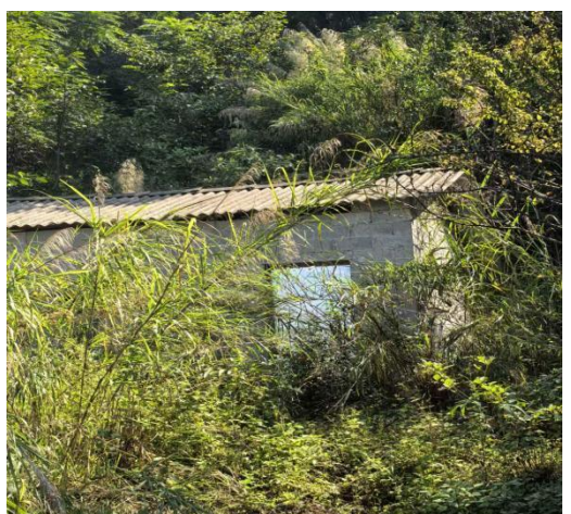
项目储油间现状
